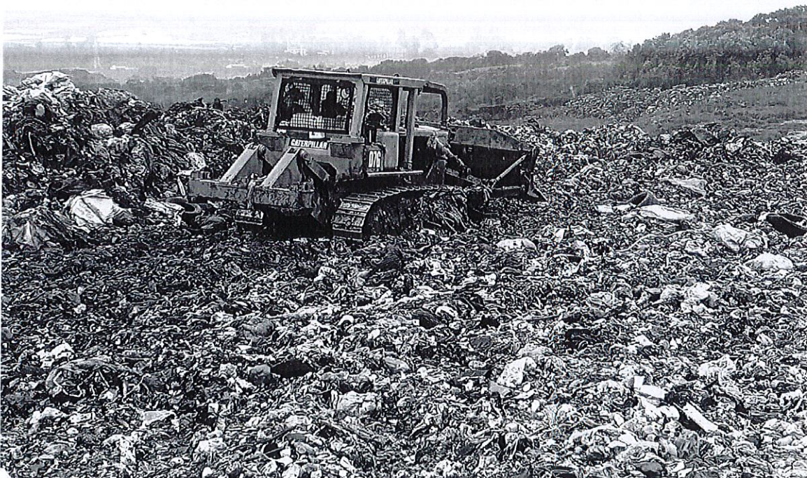
Bandeo con maquinaria pesada del material de cobertura de los Residuos Sólidos Urbanos
