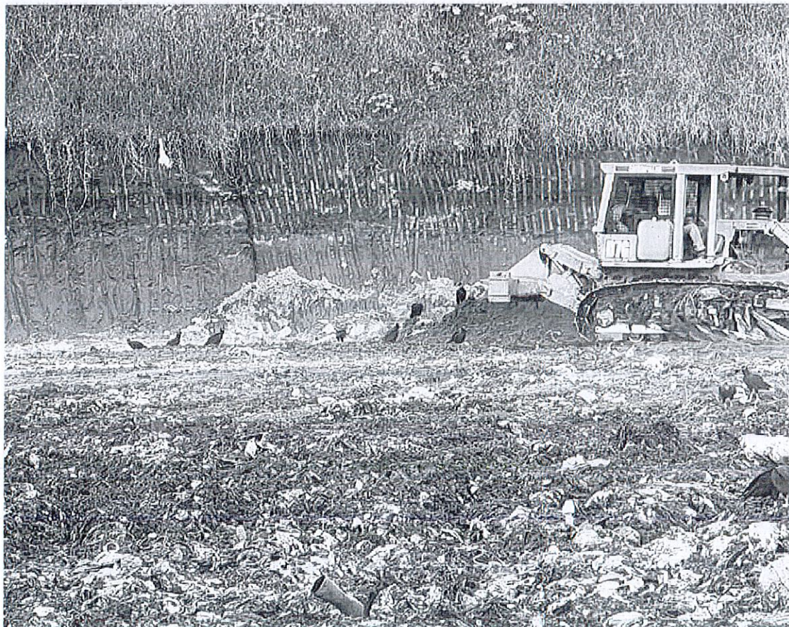
Bandeo con maquinaria pesada del material de cobertura de los Residuos Sólidos Urbanos
