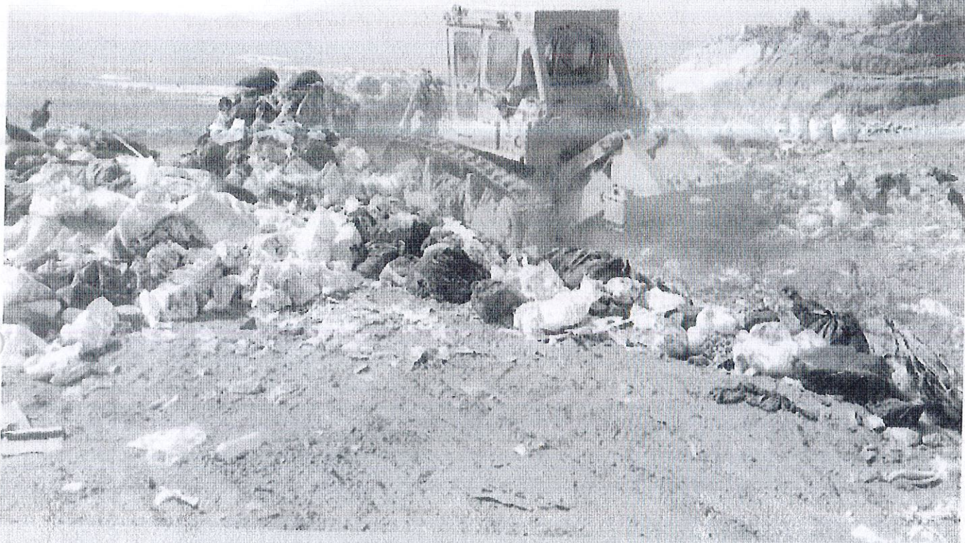
Bandeo con maquinaria pesada de los Residuos Sólidos para su compactación en el Relleno Sanitario de Zapotlán El Grande.
