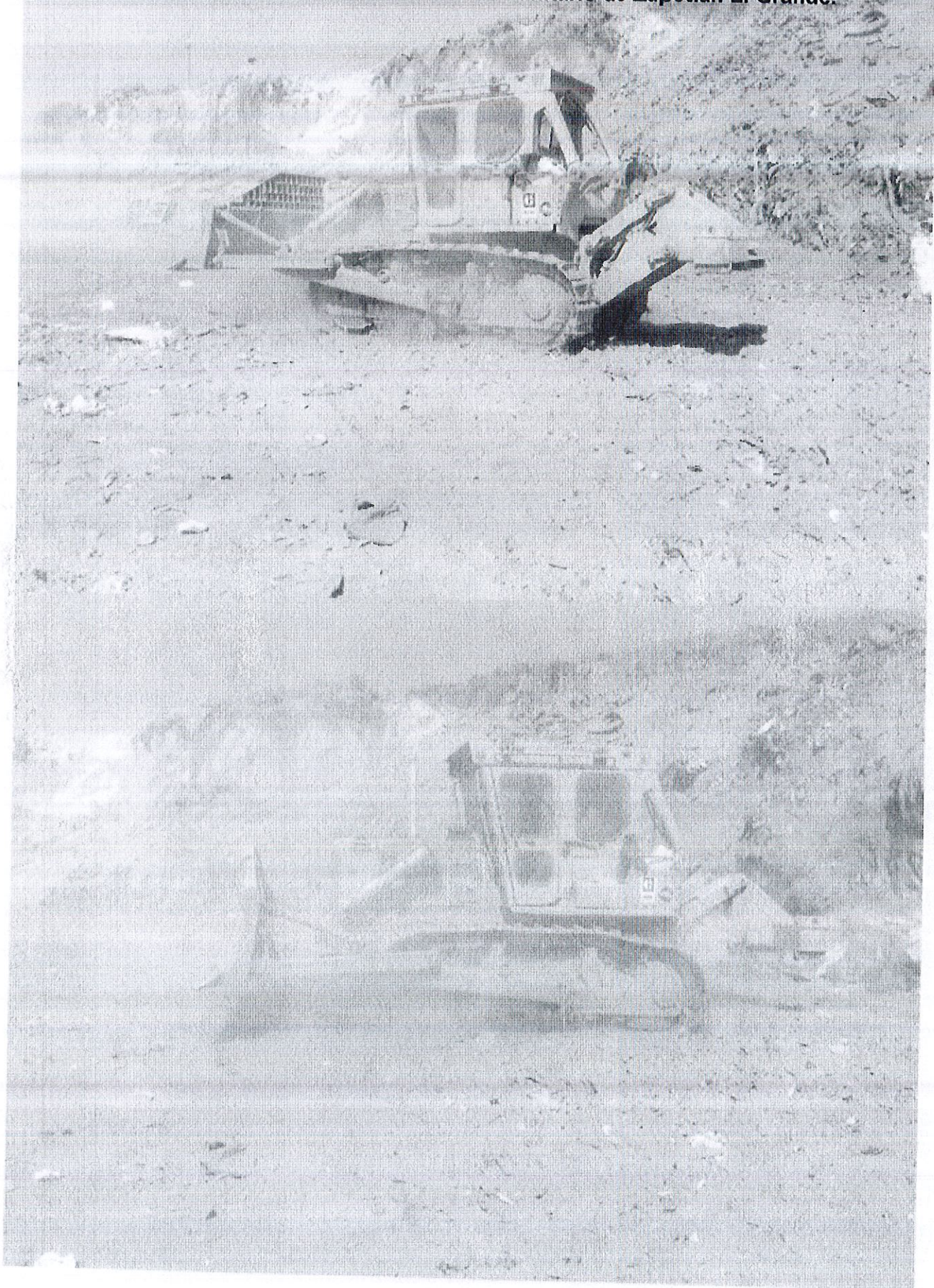
Bandeo con maquinaria pesada del material de cobertura sobre los Residuos Sólidos para su compactación en el Relleno Sanitario de Zapotlán El Grande.
