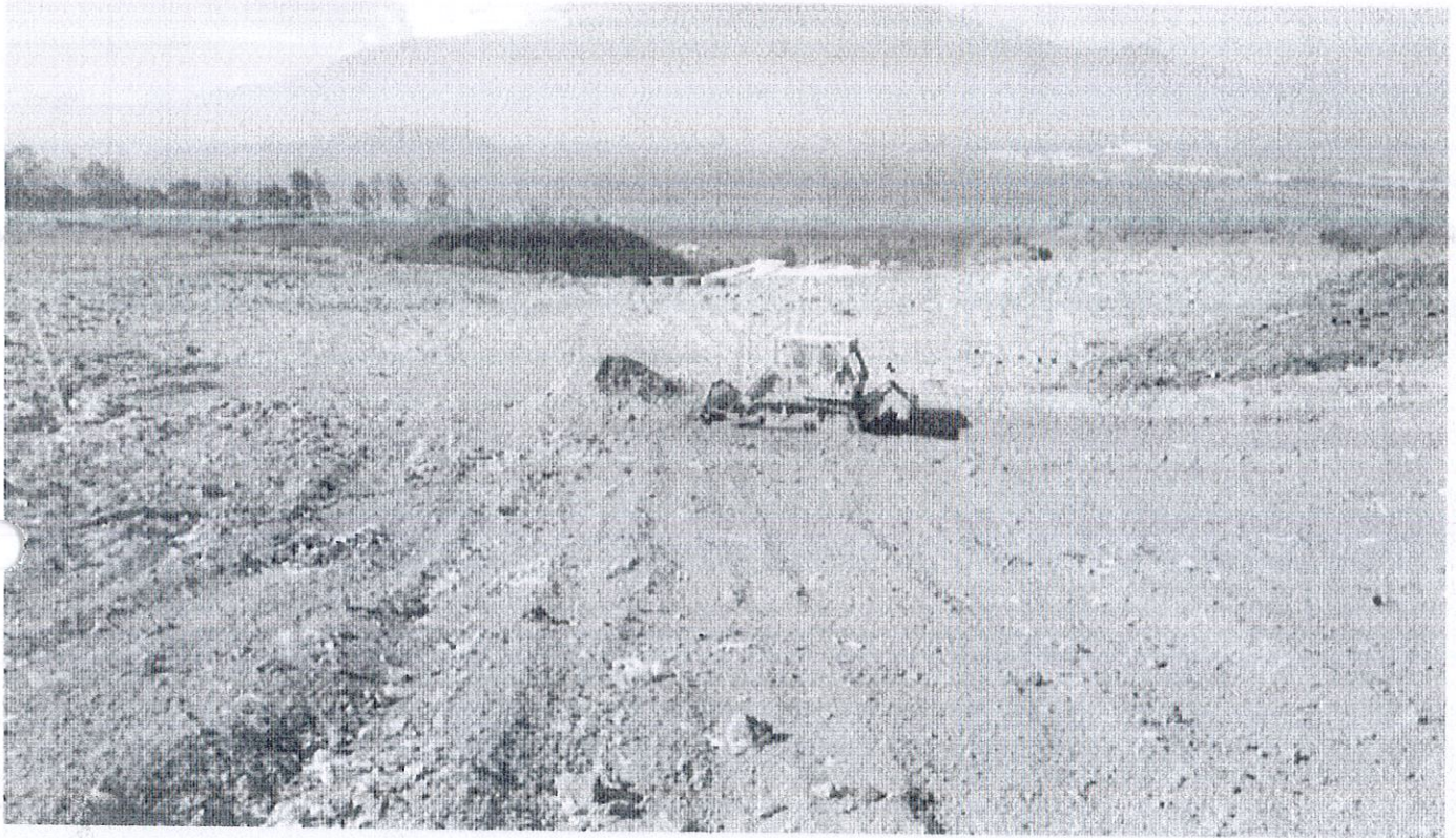
Bandeo con maquinaria pesada del material de cobertura sobre los Residuos Sólidos para su compactación en el Relleno Sanitario de Zapotlán El Grande.
