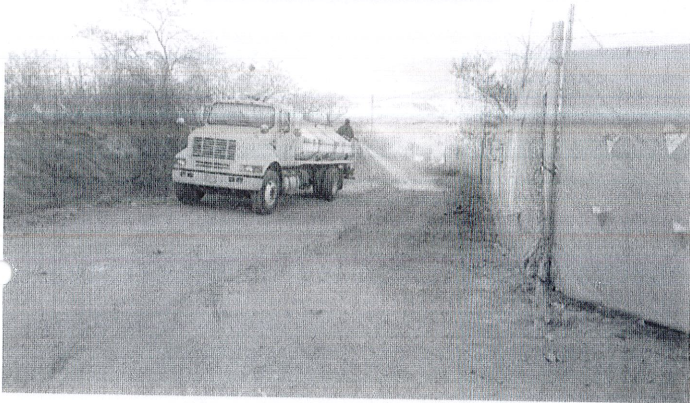
Mantenimiento del camino de acceso al Relleno Sanitario de Zapotlán El Grande.
