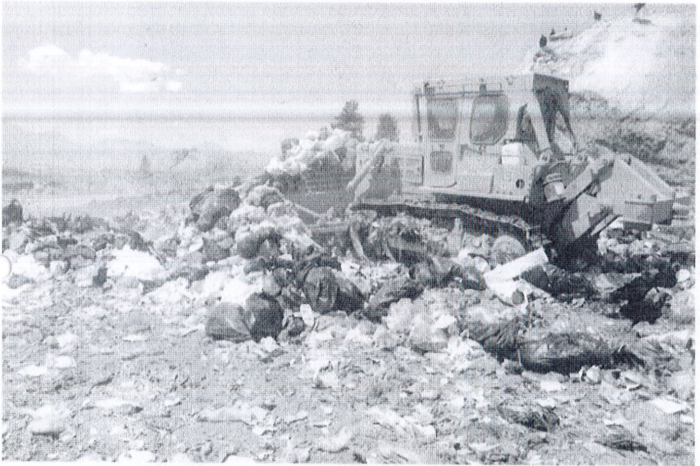
Bandeo con maquinaria pesada de los Residuos Sólidos para su compactación en el Relleno Sanitario de Zapotlán El Grande.
