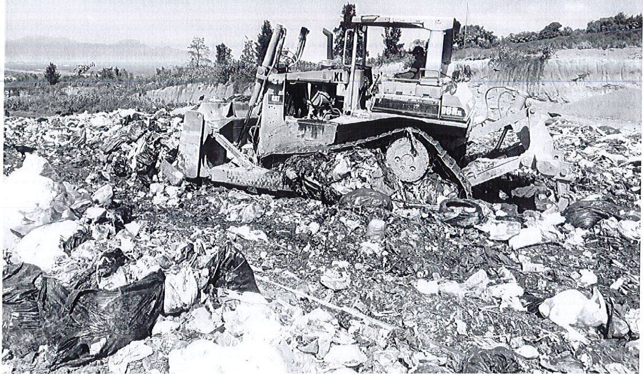
Bandeo con maquinaria pesada del material de cobertura de los Residuos Sólidos Urbanos
