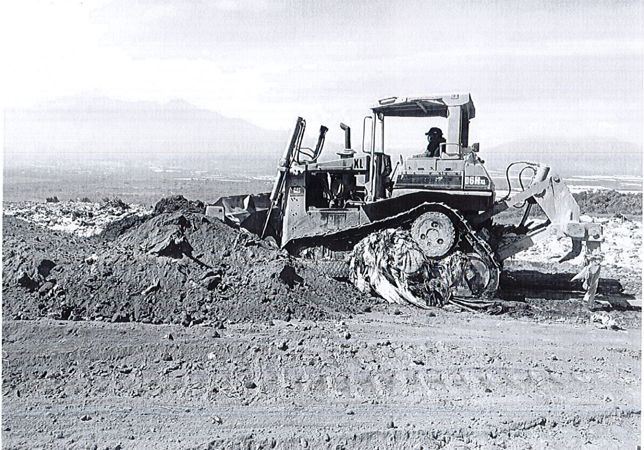
Bandeo con maquinaria pesada del material de cobertura de los Residuos Sólidos Urbanos
