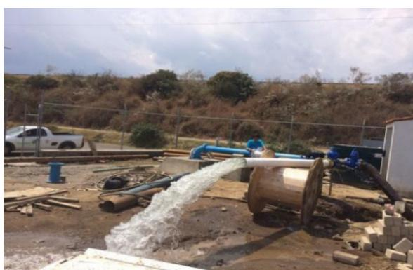
3) Pozo profundo en el Parque industrial, en el que aumentamos el gasto a 15 litros por segundo, con lo que fue posible instalar la línea de conducción de agua potable a la delegación de Apaztepetl con una longitud de 1,200 metros y se logró dotar de agua a 450 habitantes.
