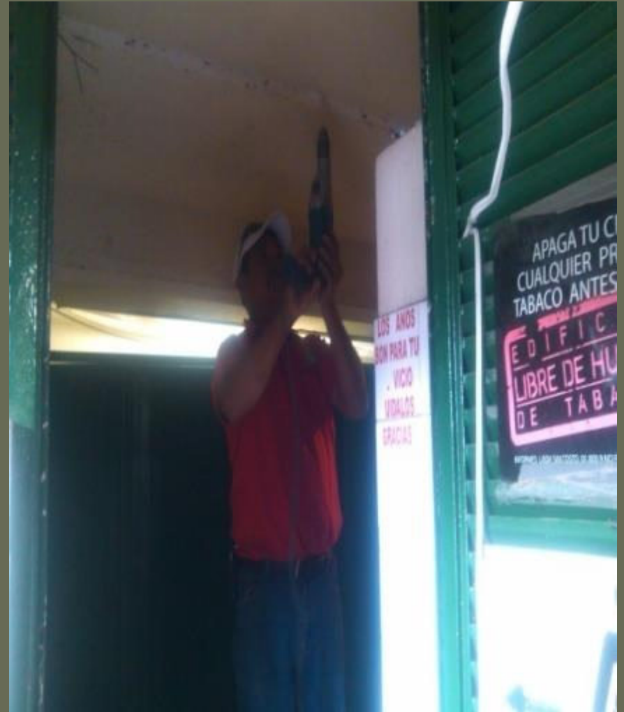
REPARACION DE BAÑOS DEL TIANGUIS MUNICIPAL
