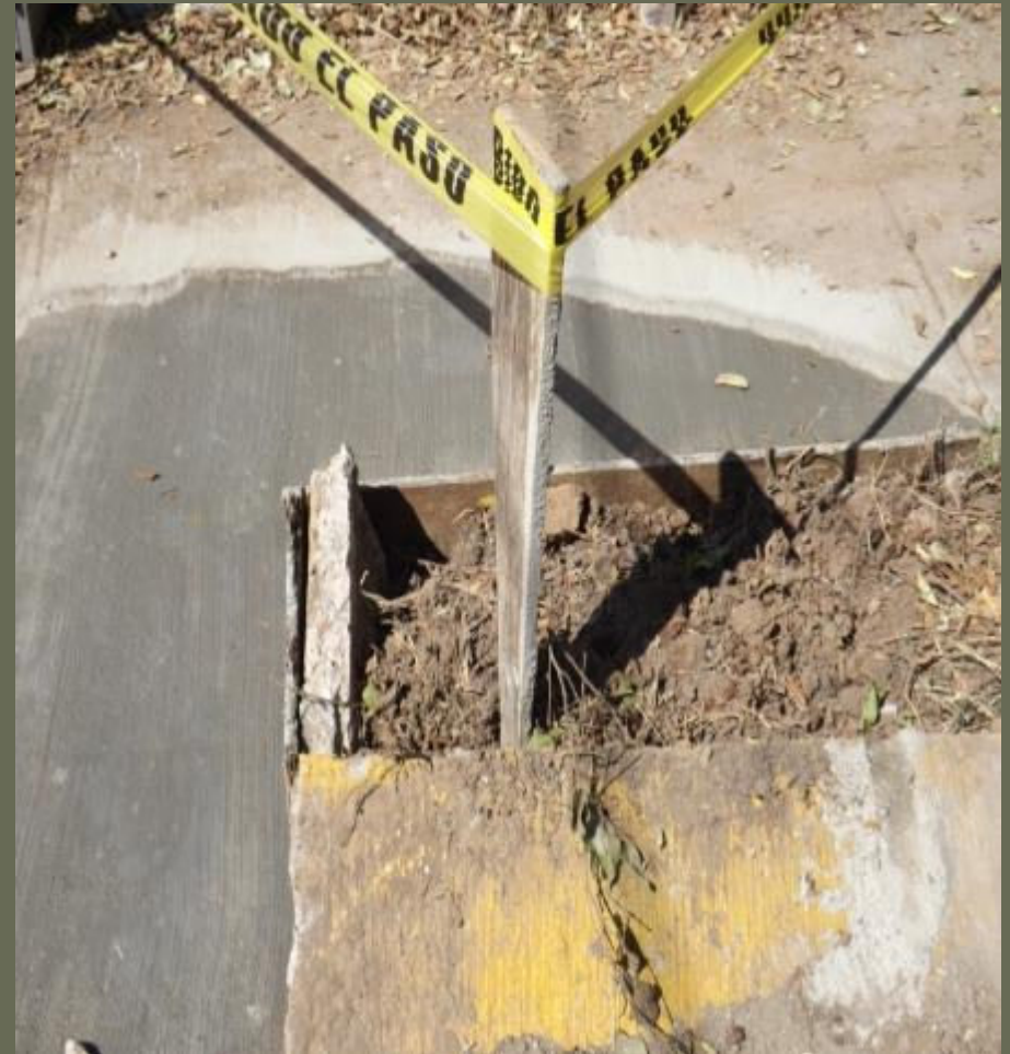
RETIRO DE ARBOL EN LA COL. LA GUIRALDA CALLE JOSE ROMERO FLORES
