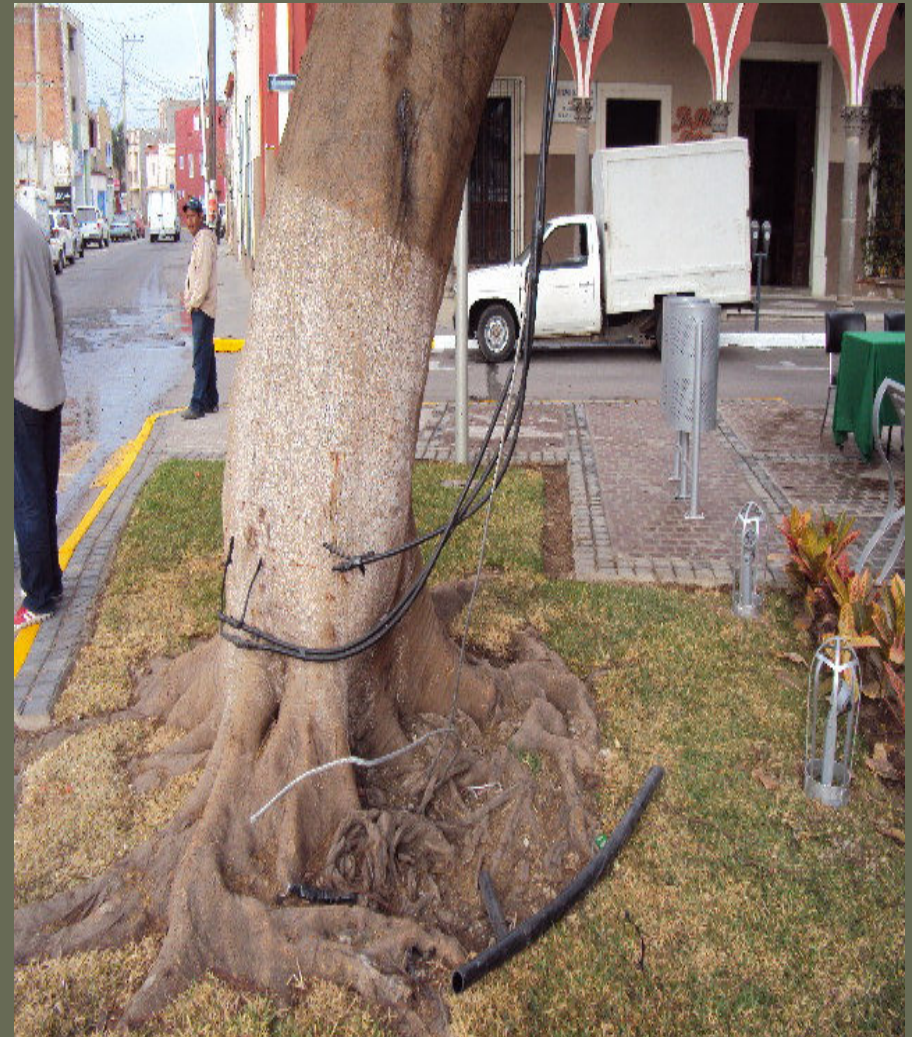
RETIRO DE ACOMETIDA EN LA PLAZUELA ING. JOSE MARIA ARREOLA
