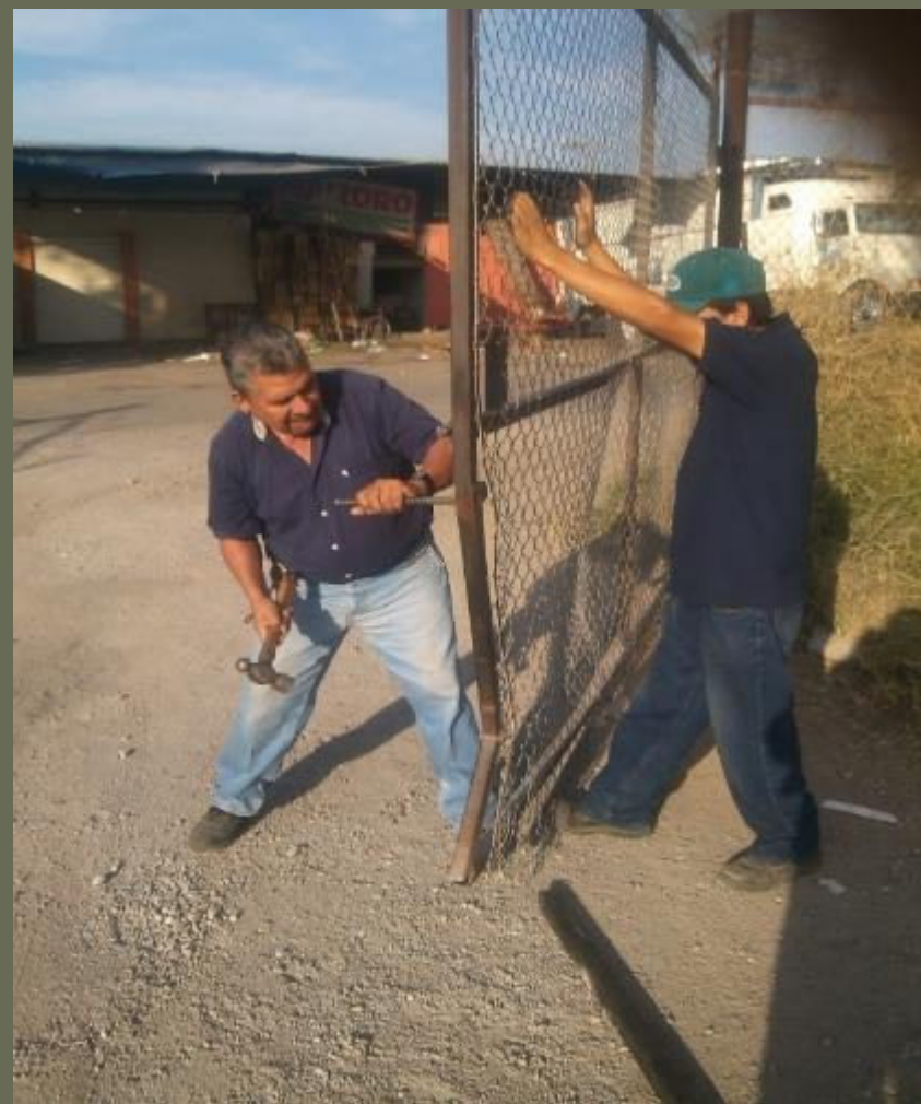
REPARACION DE MALLA DEL TIANGUIS MUNICIPAL POR EL LADO DEL CHACUACO
