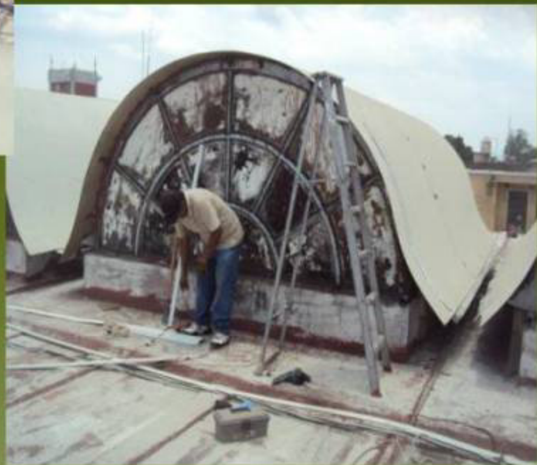
REPARACION DE DOMO DEL MERCADO PAULINO NAVARRO
